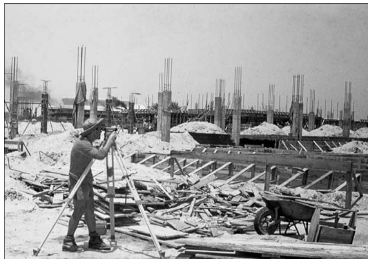
Валентин Шадрин делает разметку под новый фундамент. Потом выяснится, что он ошибся всего на несколько сантиметров
