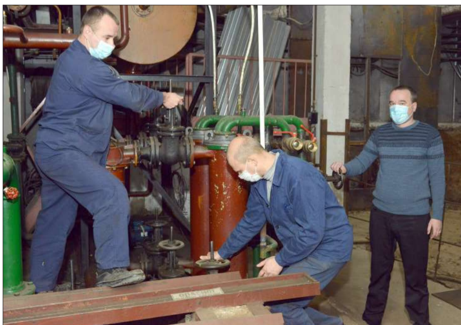
Мастер А. С. Лукашенко (крайний справа) контролирует ремонт задвижек
