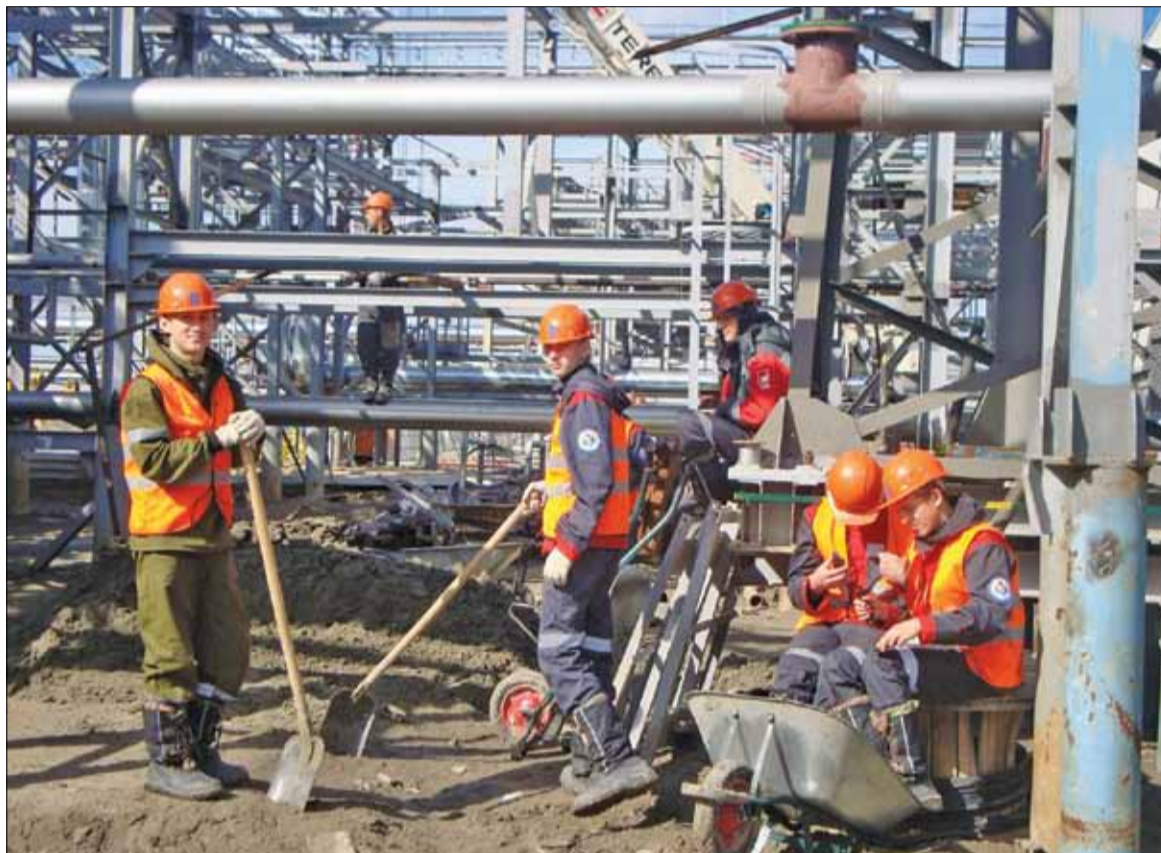
Газоперерабатывающий завод. На Ямале всё строится на песке, а здания подняты над землёй на сваях
