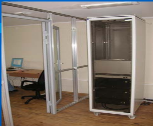
Стойка с приемной аппаратурой
