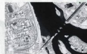
Мониторинг строящихся объектов: мост через р.Ангару, г.Иркутск (по данным ИСЗ EROS-A)
